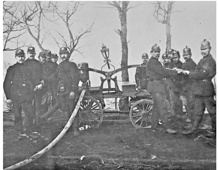
Deshalb waren die Twieten für die Löscharbeiten so wichtig: Am Plöner See entnahmen die Feuerwehrleute das Wasser. Die verwendeten Schläuche bestanden aus Hanf.
